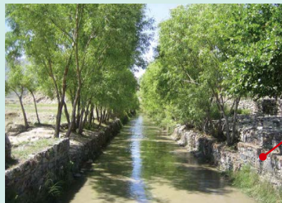
ジャカゴ 蛇籠を利用した マルワリード用水路
