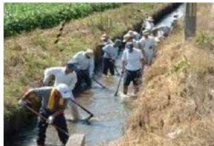
水路の土砂さらい
